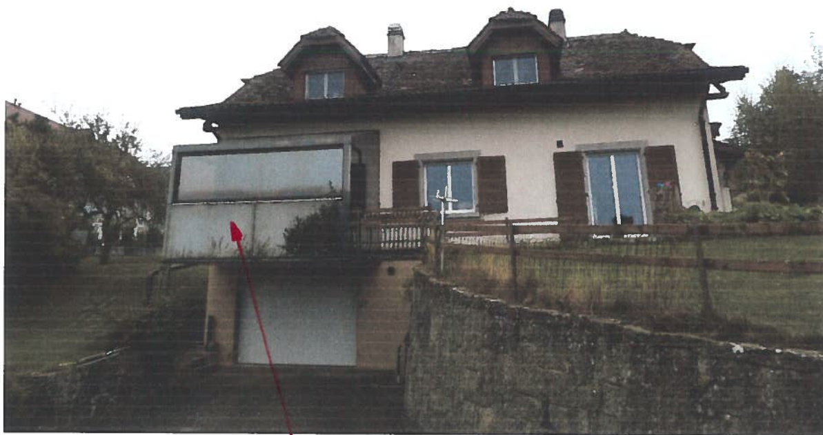
Façade NORD-OUEST Véranda existante à démolir
