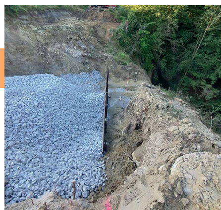
RAILS, PALPLANCHES ET CHAILLE DE DRAINAGE
