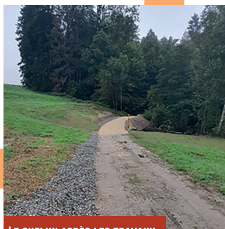
LE CHEMIN APRÈS LES TRAVAUX
