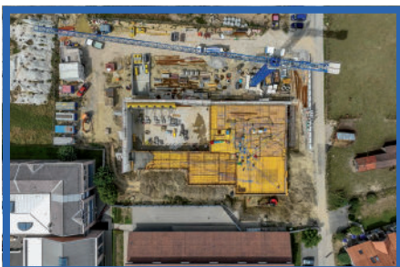
COULAGE DU REZ SUPÉRIEUR
