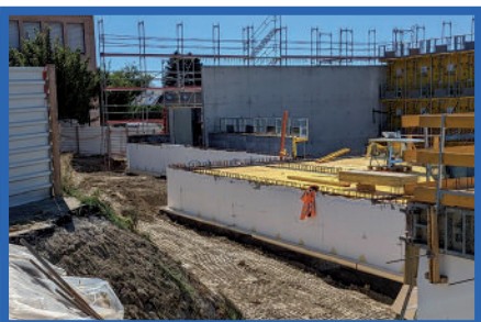
REMBLAIEMENT PÉRIPHÉRIQUE DU REZ INFÉRIEUR
