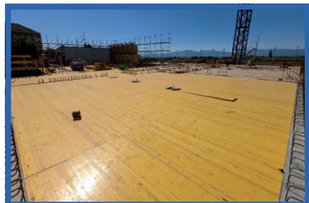
COFFRAGE DE LA DALLE DU REZ SUPÉRIEUR
