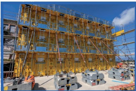
COULAGE DU MUR DE LA SALLE DE GYM
