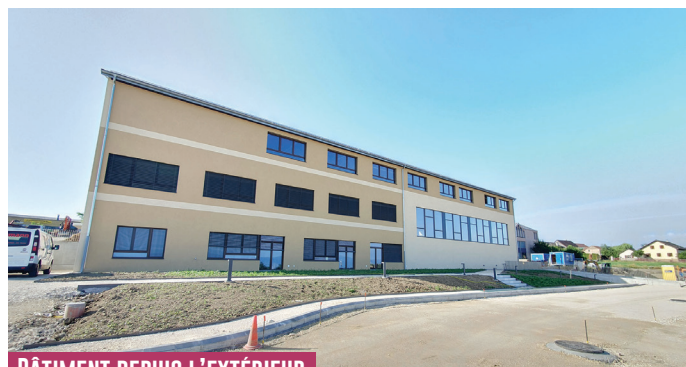
BÂTIMENT DEPUIS L'EXTÉRIEUR
