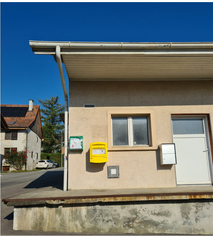
Neyruz Pilier public (ancienne laiterie)
